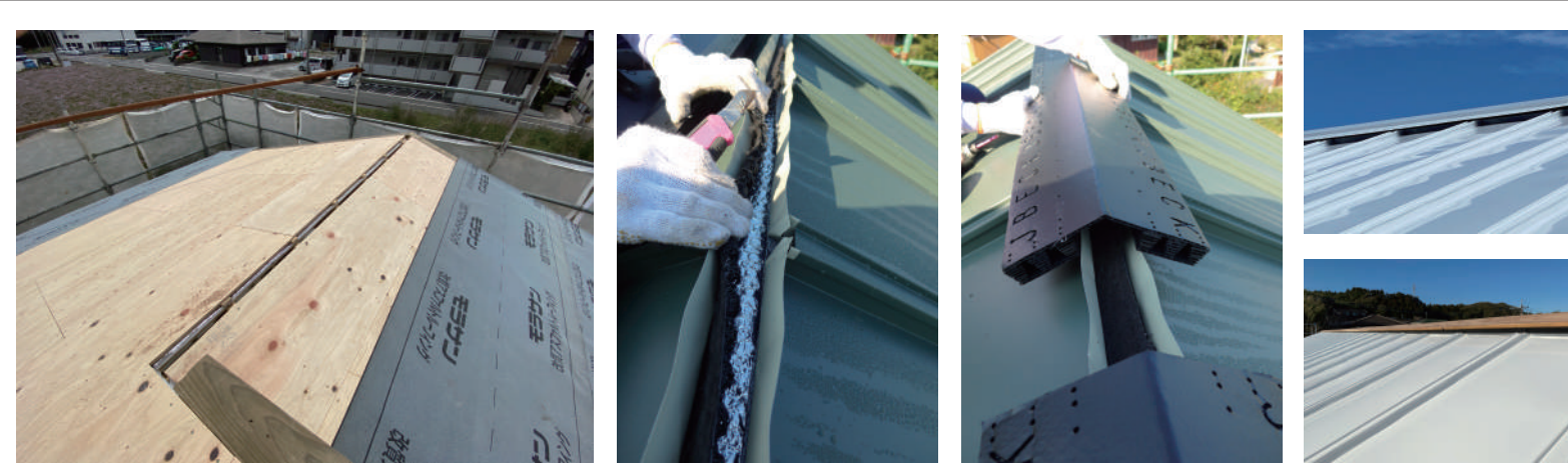
■ PP製の屋根棟換気材、耐久性高く風速60mの暴風雨でも雨水を侵入させない事が謳ってある。
