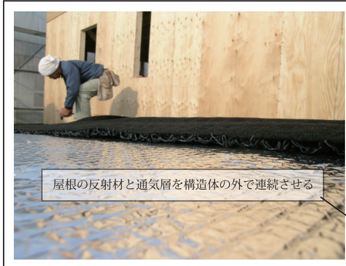
■ 屋根の材料に合わせ構造用合板を下地として通気層を確保する場合がありますが、いずれも棟換気を設置します。
