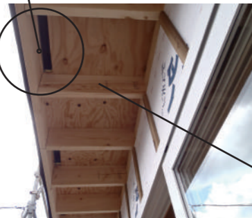
■ 壁の通気層を屋根外気側に連続させるための納まりの工夫。防風にも耐えられるように工夫を凝らしてある。
