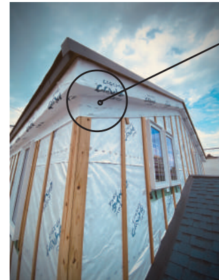
■ 壁の通気層を屋根外気側に連続させるための納まりの工夫。防風にも耐えられるように工夫を凝らしてある。
