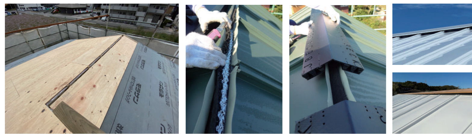
■ PP製の屋根棟換気材、耐久性高く風速60mの暴風雨でも雨水を侵入させない事が謳ってある。
